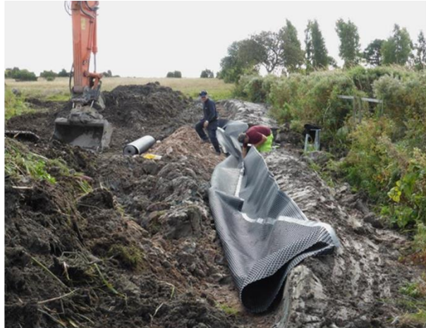
Bygget av vällen vid utloppet i september 2015.
