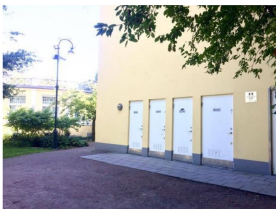
Exmpel från Malmö integrerad i annan byggnad
