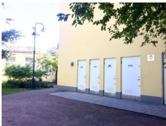
Exmpel från Malmö integrerad i annan byggnad
