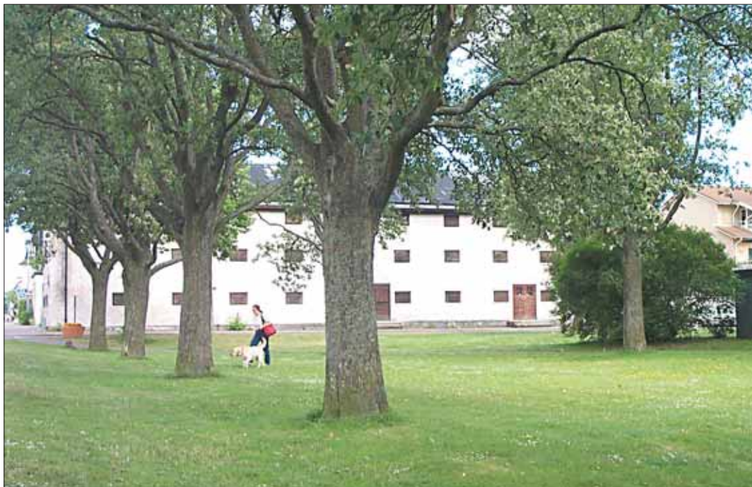
Byggnadsminnet Kronomagasinet uppfördes i samband med stadens tillblivelse i början av 1800-talet. Idag används en del av byggnaden som kommunal fritidsgård och utställningslokal. De två ej ianspråkta övre våningarna är en stor resurs för framtida kulturverksamhet.
