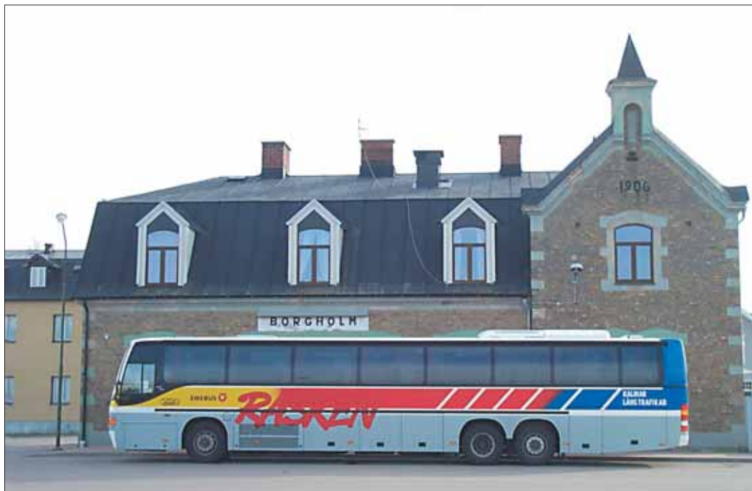
Bussarna har ersatt tågen vid Borgholms f.d. järnvägsstation som blivit "Resecentrum". Till vänster skimtar det forna järnvägshotellet.
