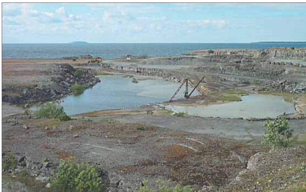
Stenbrottet i Gillberga i Persnäs socken, är ett riksintresse för att säkra tillgången på byggnads- och monumentsten.
