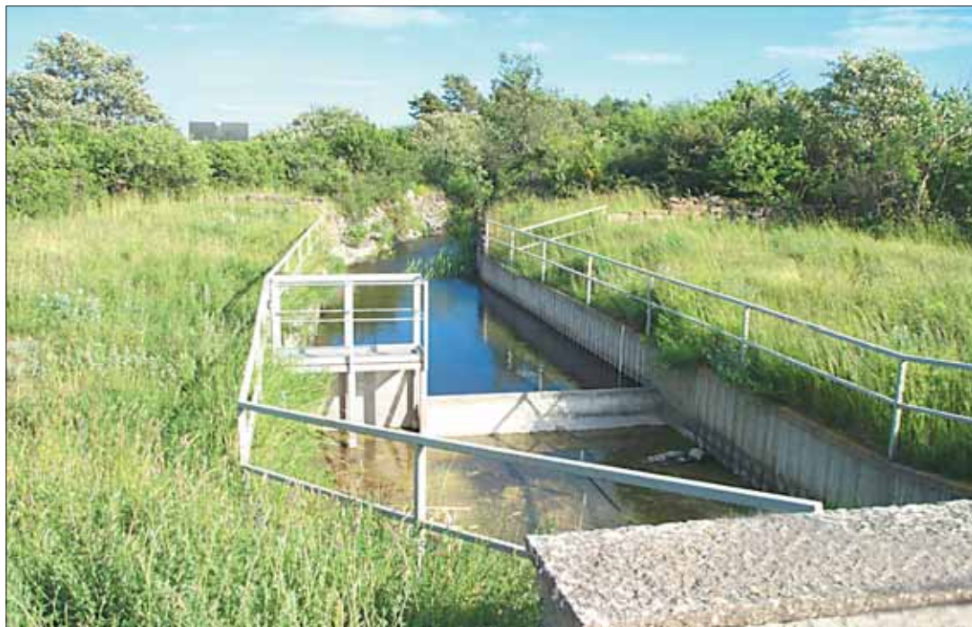
Hornsjön utgör en viktig del i norra Ölands färskvattenförsörjning. Bilden visar den fördämningsanordning vid utloppet i Kalmarsund som reglerar sjöns vattennivå.
