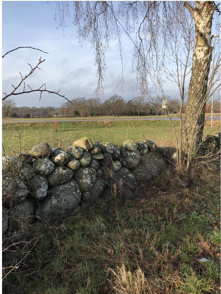
Bild 11. Stenmurar åt öster och söder
