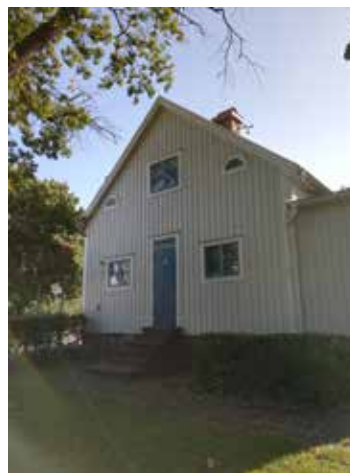
Bild 30. Exteriör grindstugan, fasad mot norr
