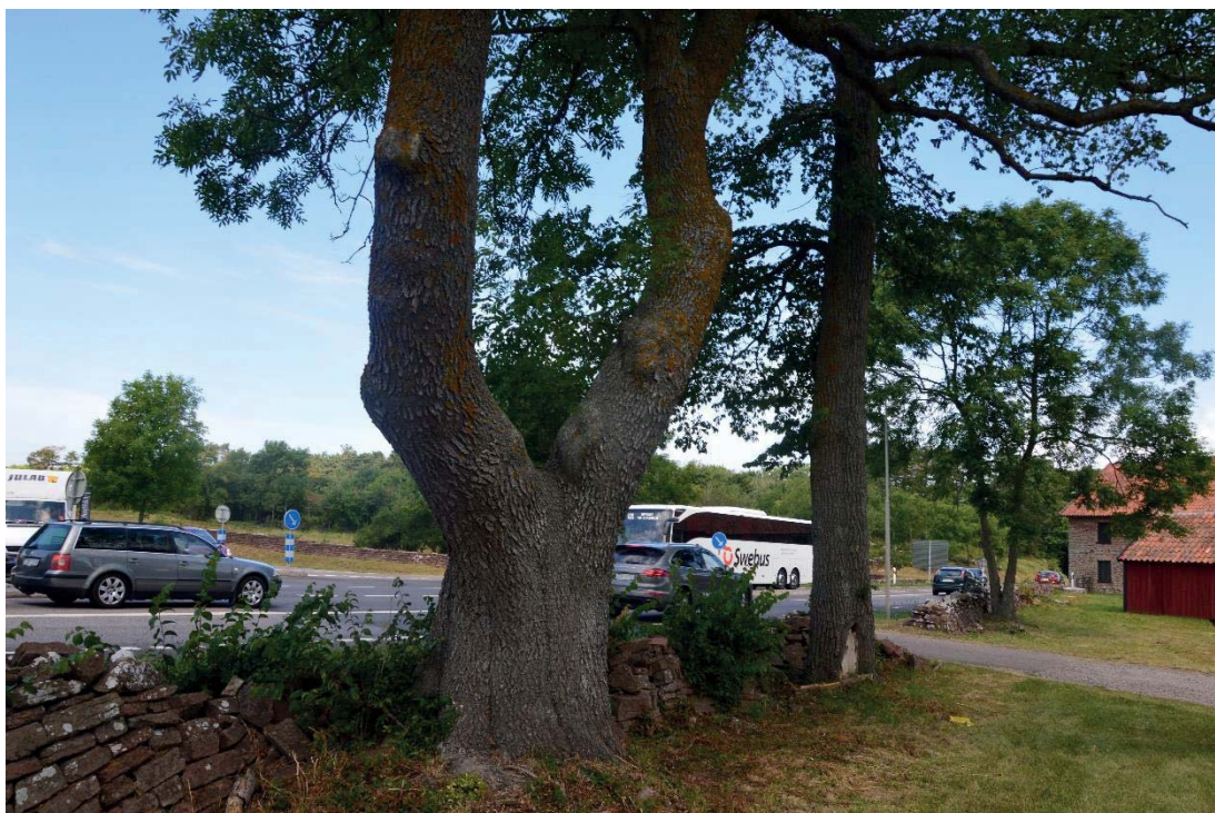
Område 10, som utgörs av en gårdsmiljö vid Vasahuset. Naturvärdet i området bedöms vara högt med bland annat förekomst av gammal ask och alm. Risker med almsjukeangripna träd finns dock. Trädet till höger i bilden, med stamskada, bör snarast fällas på grund av sjukdomsangrepp.
