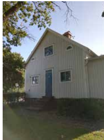
Bild 30. Exteriör grindstugan, fasad mot norr
