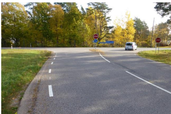
Korsningen Stora Rörsvägen och väg 136
