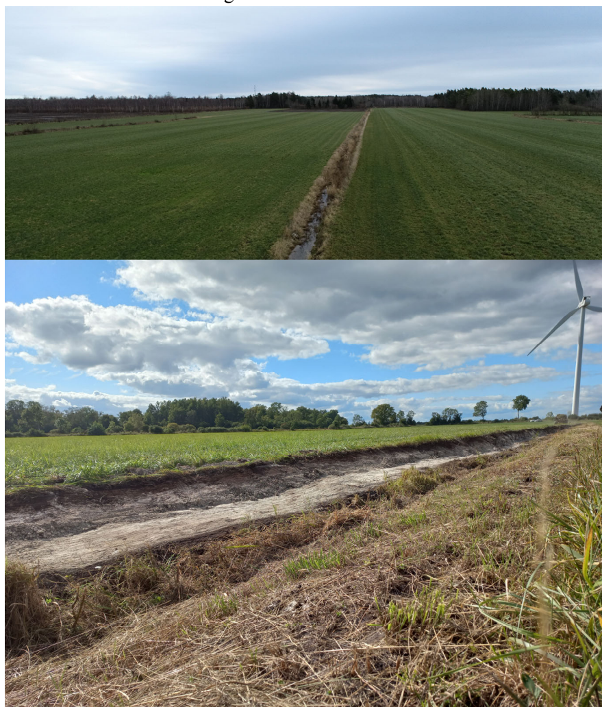
Figur 5. Före och efter grävning av de långsträckta våtmarkerna, så kallade tvåstegsdiken.
