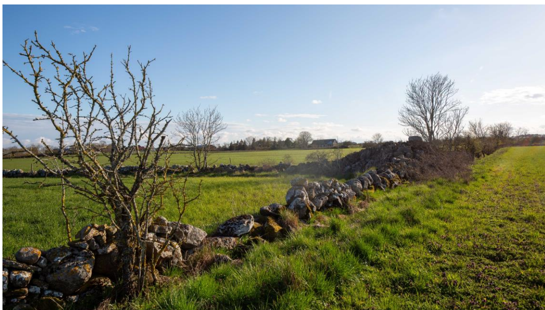
Bild 12 visar plats där mur behöver tas bort för att tillhandahålla alternativ insatsväg för räddningstjänsten. Berörd del av muren är hitom röset i bildens borte del. Bild fotograferad från murens norra sida, inom anläggningsområdet, mot sydväst. Foto: Stefan Fahlstedt.
