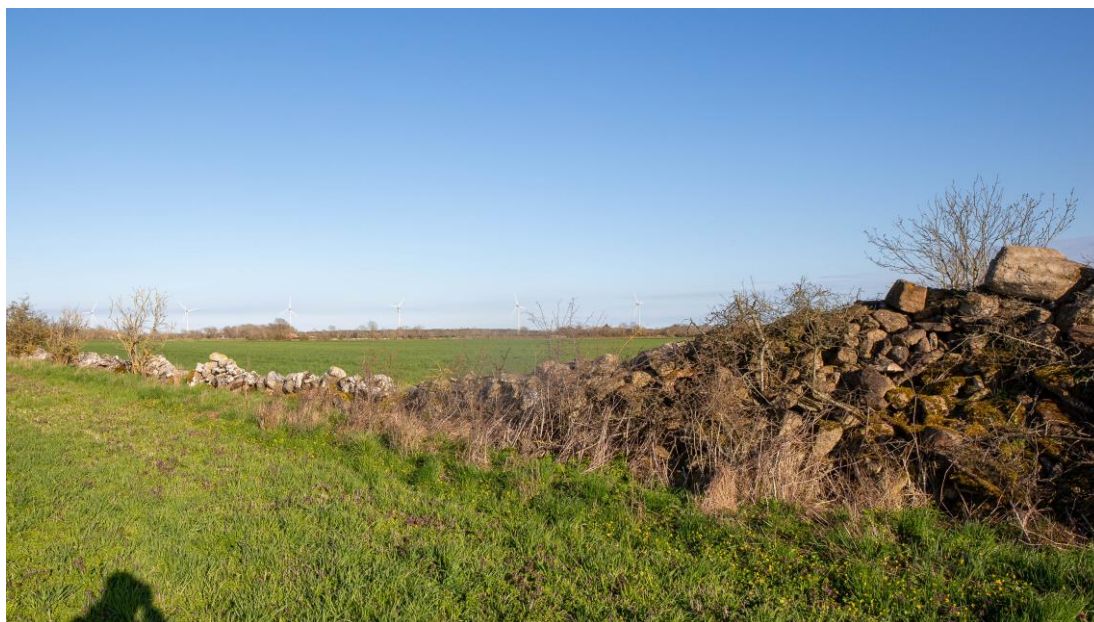
Bild 13 visar plats där mur behöver tas bort för att tillhandahålla alternativ insatsväg för räddningstjänsten. Berörd del av muren är bortom röset i bildens högra del. Bild fotograferad från murens norra sida, inom anläggningsområdet, mot sydost. Foto: Stefan Fahlstedt.
