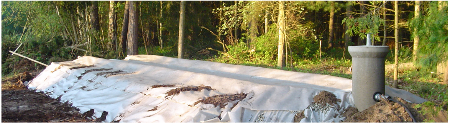
Anläggning av en infiltration Foto: Borgholms kommun
