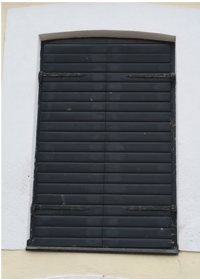
Äldre öppningar med träluckor
