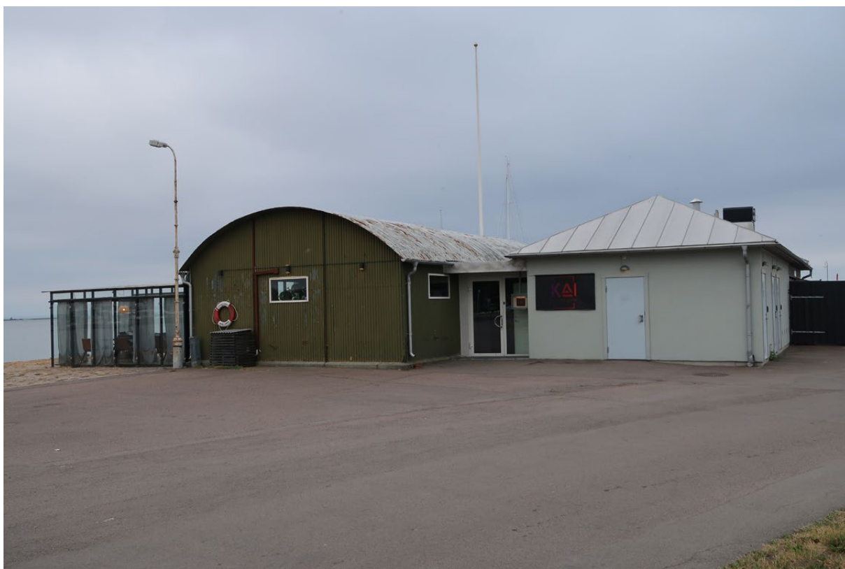
Den ursprungliga byggnadskroppen framträder tydligt trots senare ändringar och tillägg.
