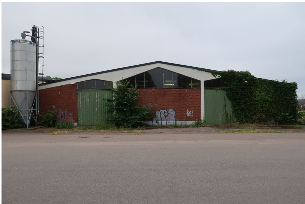
Tegelfasaden på magasinet.
