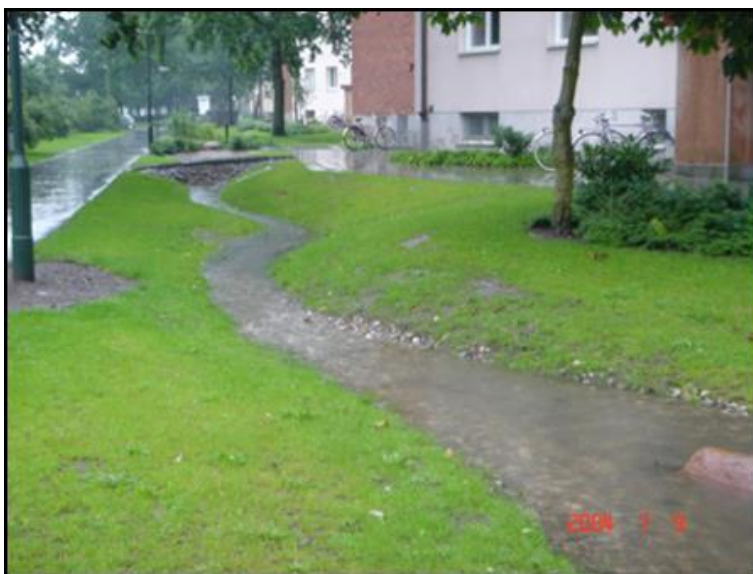
Figur 3-6. Exempel på svackdike invid bebyggelse. (Bild: VA Syd)
