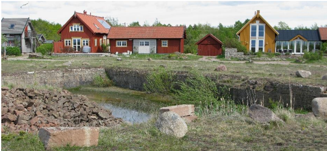
Flera lämningar efter stenbrott finns i området A. Här intill tre nybyggda hus från år 2000. Dessa skiljer sig från övriga sommarstugor i området, vilka har lägre och nättare skala.
