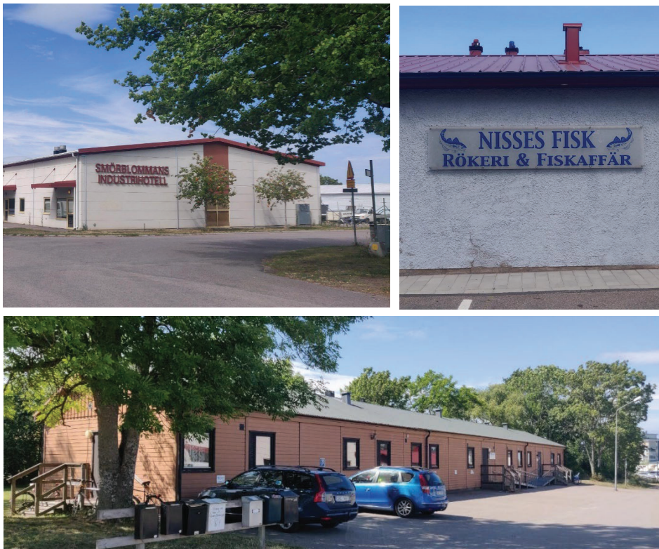
Figur 14. Bebyggelse i de södra delarna av planområdet. En låg bebyggelse i gråtonade och lågmälda kulörer.
