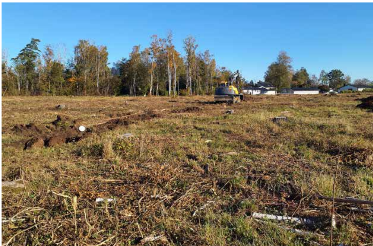
Figur 4. Översiktsfoto över den östra delen av exploateringsytan. Foto från VSV.
