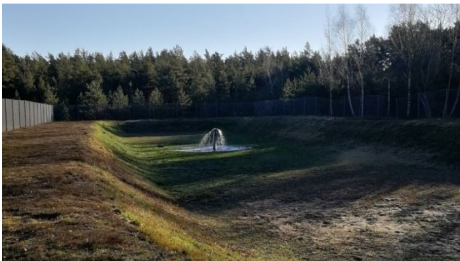
Infiltration av ytvatten vid Solbergafältet.
