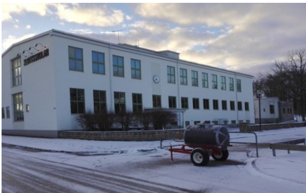
Tillfällig nödvattentank uppställd på grund av vattenläcka.
