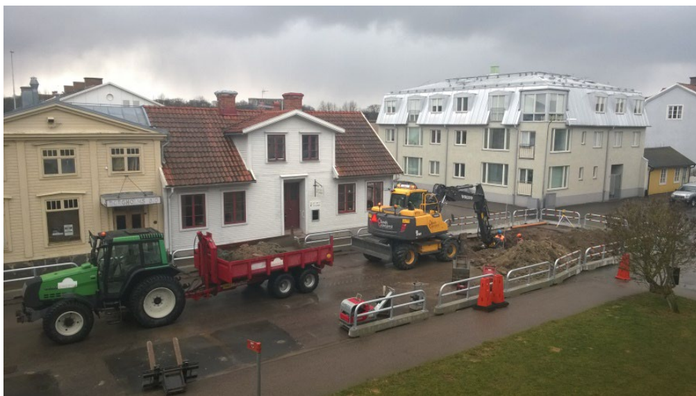
Arbete på ledningsnätet i Borgholms stad.
