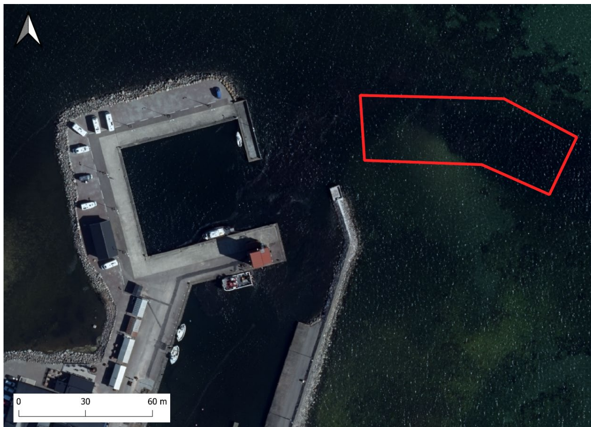
Figur 1. Översiktsbild av Kårehamns hamninlopp. Planerad yta för muddring är markerad i rött.
