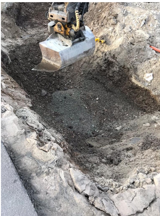
Figur 1. Fotografi över schaktgrop, naturligt material i botten.
