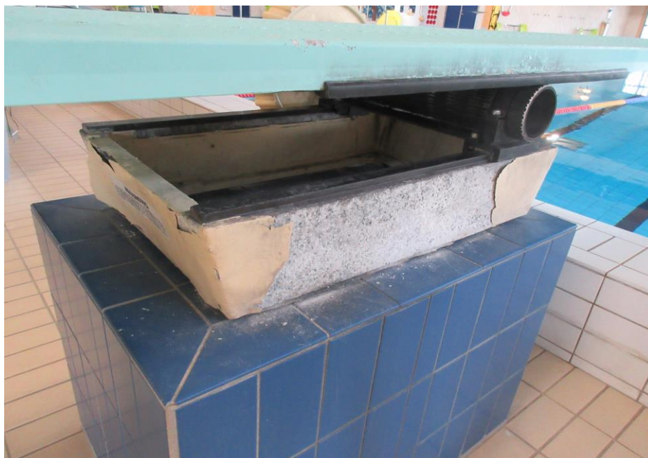
Bilden visar fundamentet till trampolinen.
