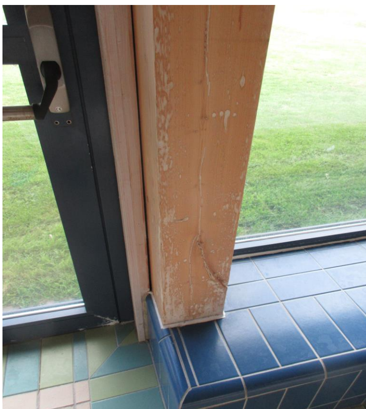
Bilden visar limträpelare i norra fasaden.
