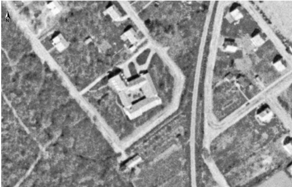
7. Flygbild från 1960 visar byggnadens ursprungliga storlek.
