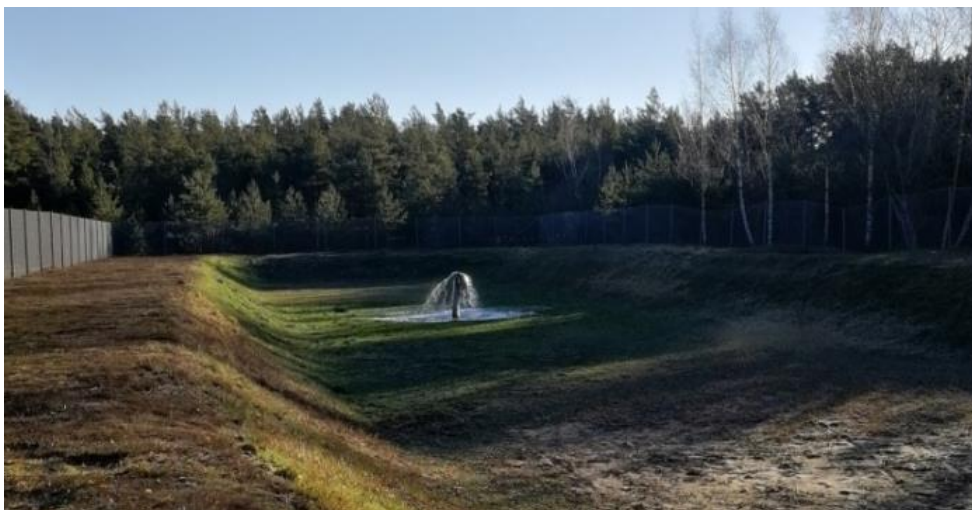
Infiltration av ytvatten vid Solbergafältet.
