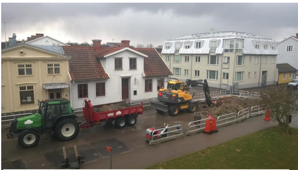
Arbete på ledningsnätet i Borgholms stad.
