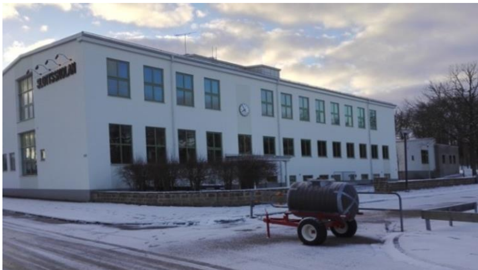
Tillfällig nödvattentank uppställd på grund av vattenläcka.
