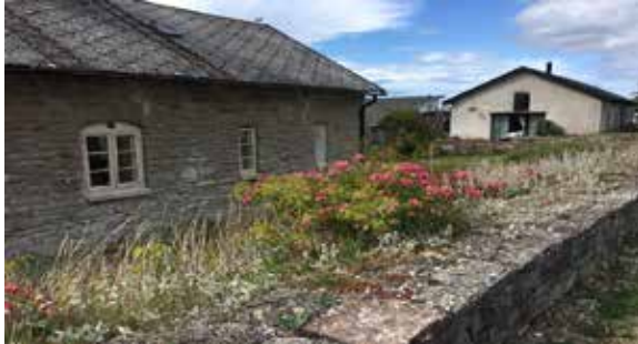
Stenhusen norr om tidigare brukskontoret
