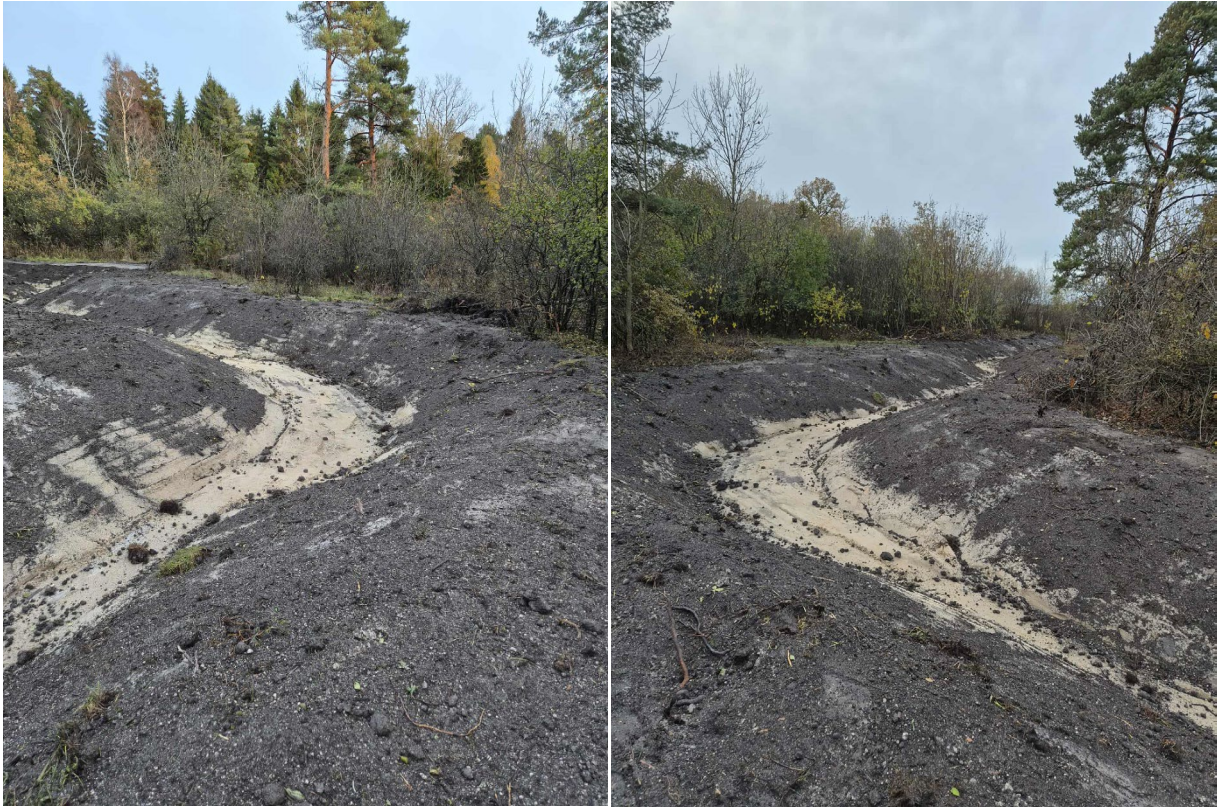
Figur 5. Det mellersta diket dominerades av sand. Platsen medgav flera svängar vilket bedöms bidra ytterligare till att sänka hastigheten på vattnet.
