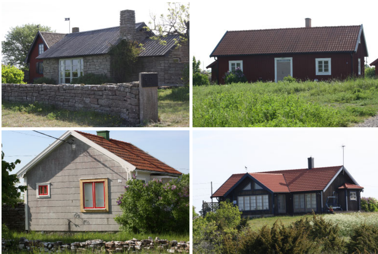
Bild 21. Exempel på bebyggelse inom området från småställen via äldre fritidshusbebyggelse mot modernare mer storskalig bebyggelse
